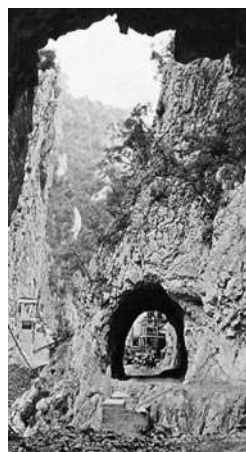
Izgradnja pruge na dionici Lutovo – Krušev potok...
